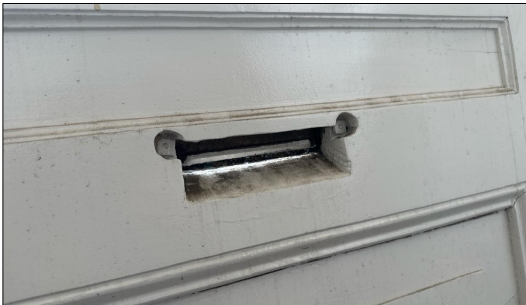
Figuur 2: Plaats een brievenbus brostel om warmteverlies te beperken.
